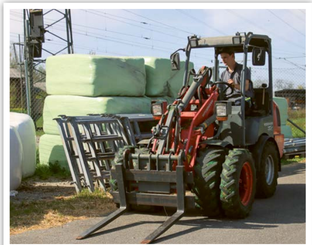
Jonas Bauer transporte en tracteur du matériel pour construire la piste principale. (Photos : Franziska Schawalder)
